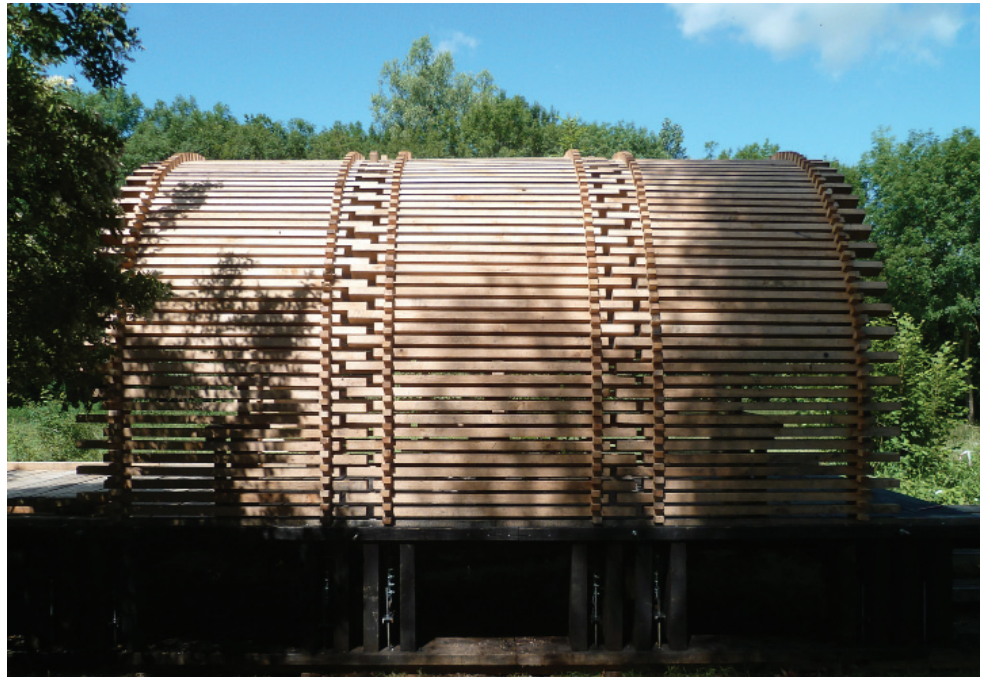
Les assemblages à sec des clefs forment le rayon de courbure des tronçons de voûte; ces tronçons s'entrelacent mais jamais ne se touchent.
