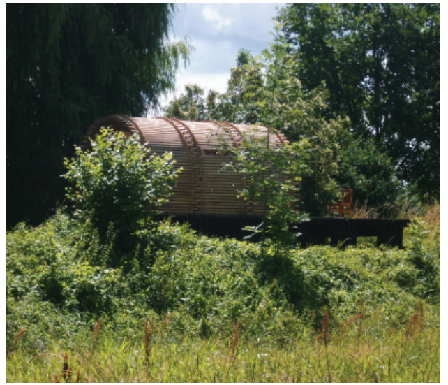
Le refuge s'adapte aux variations des milieux naturels inondables, il repose sur le sol en période sèche et flotte en période de crue.
