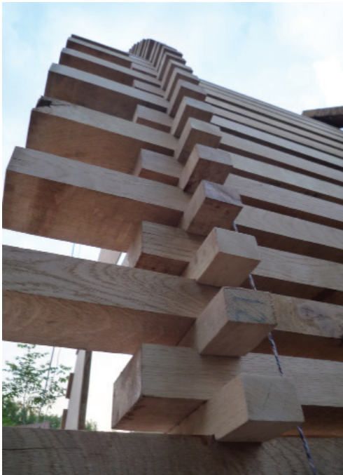
Les assemblages à sec des clefs forment le rayon de courbure des tronçons de voûte; ces tronçons s'entrelacent mais jamais ne se touchent.
