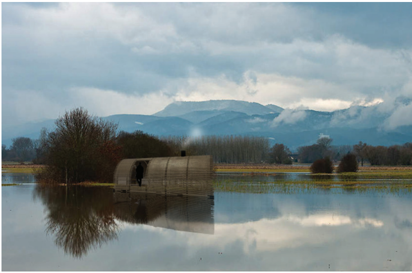
Le refuge s'adapte aux variations des milieux naturels inondables, il repose sur le sol en période sèche et flotte en période de crue.
