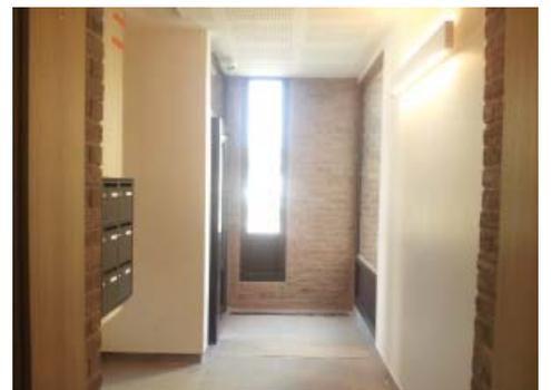
Extensions de halls pour la barre D. Elles ont été réalisées en briques de terre cuite constructive pour deux des façades, en panneaux de bardage coloré pour les autres
