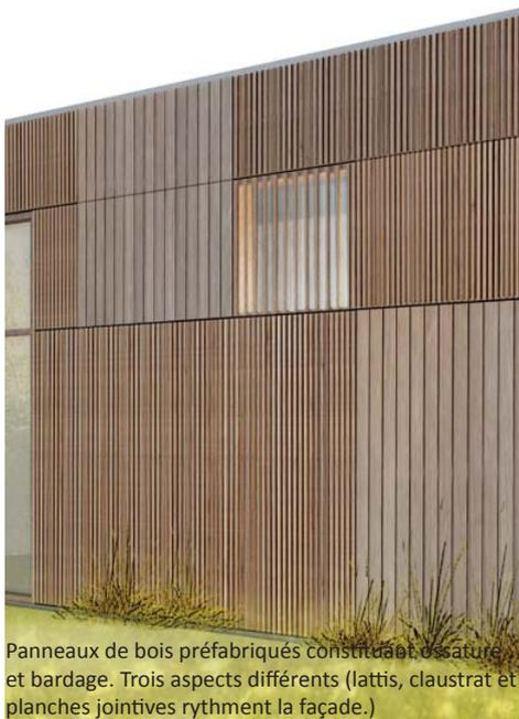
Panneaux de bois préfabriqués constituant ossature et bardage. Trois aspects différents (lattes, claustrat et planches jointives rythment la façade.)
